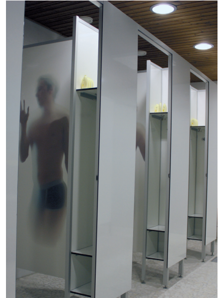
Erikoisjakoseinä, digitalprintlaminaattia, Biitsi, Salmisaaren liikuntahalli
