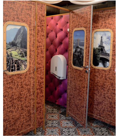
LTT 24 mm, printtilaminaatti, polttomaalattu alumiiniprofiilirunko, Linnanmäen Ratalaakso
