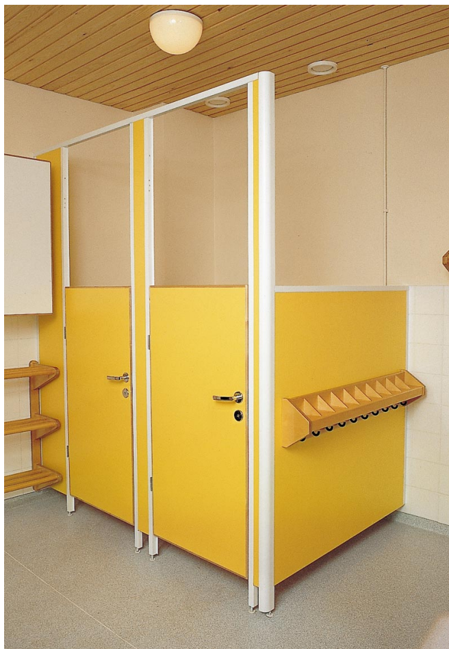
Un perete despărțitor de WC din grădinița de copii din panel LTT de 24 de mm.
