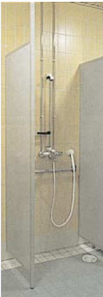
Dušas šķērssienu tiek izgatavota no 10 vai 13 mm biezas kārtainās plāksnes. Griestu stiprinājums.
